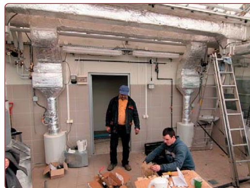
Prace modernizacyjne w szklarni
