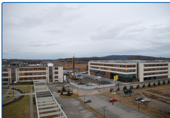
Plac budowy Małopolskiego Centrum Biotechnologii
