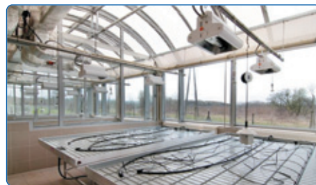
Odbiór komisyjny prac Szklarni Doświadczalnej
